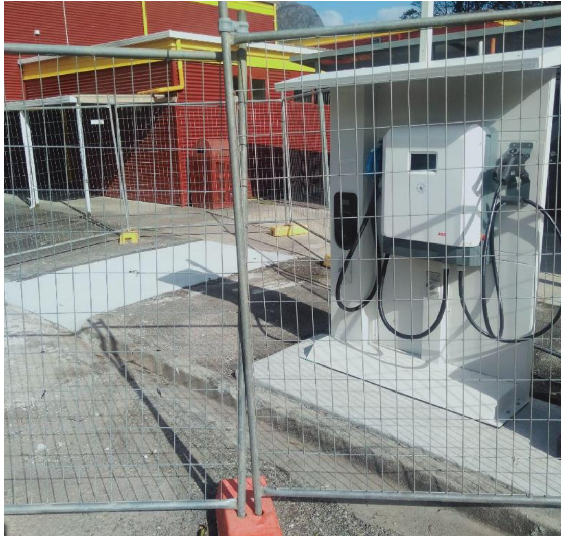
Tullah (EHT) – in build
